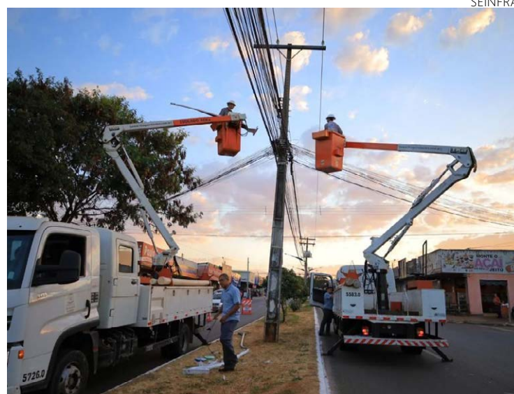
Modernização da iluminação pública no trecho urbano da BR-153 aguarda autorização de concessionária
